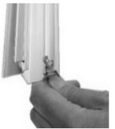
Schrauben Sie die Profile zusammen, indem Sie die Vierkantschrauben in den Profilkanal schieben und am Loch im entsprechenden Balken befestigen. Ziehen Sie die Muttern erst dann fest, wenn der Rahmen vollkommen rechtwinklig ist. **ALLE ANSCHLUSSPROFILE MÜSSEN BÜNDIG UND FEST VERBUNDEN SEIN, UM UNDICHTIGKEITEN AUF EIN MINIMUM ZU REDUZIEREN.**
