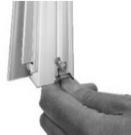
Fest profilene sammen ved å føre boltene med firkanthode inn i profilenes spor og feste dem i hullene i tilstøtende stenger. Stram ikke mutterne helt til før hele rammen er i rett vinkel. **VÆR OPPMERKSOM PÅ AT ALLE TILSTØTENDE PROFILER MÅ VÆRE I FLUKT OG SITTE TETT SAMMEN FOR Å SIKRE AT LEKKASJER HOLDES TIL ET MINIMUM.**
